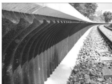
Obrázek č. 1 (vlevo) – PHS s pohltivou vrstvou z gumového recyklátu
