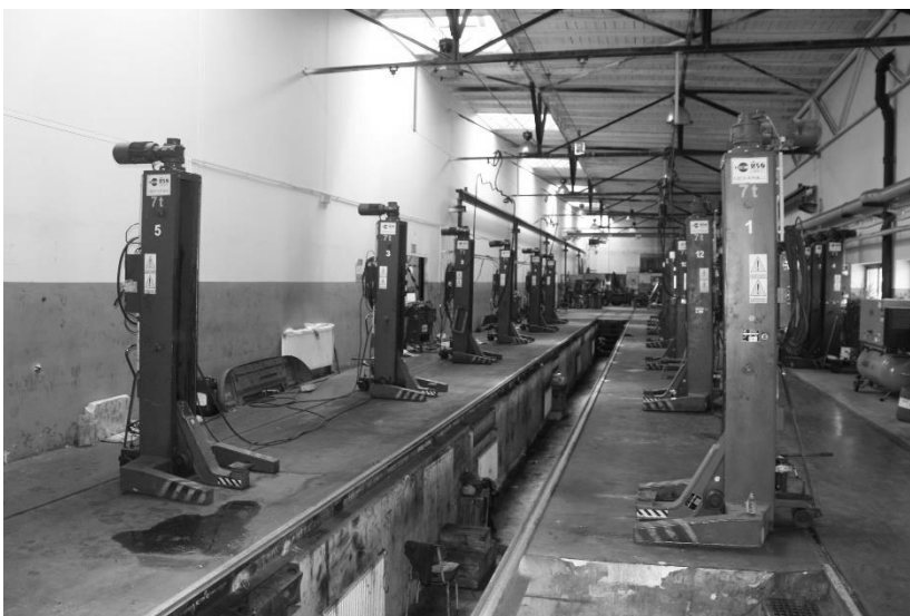
Obrázek č. 6 – Stanoviště pro zvedání tramvaje
