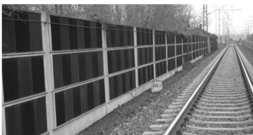
Obrázek č. 1 (vlevo) – PHS s pohltivou vrstvou z gumového recyklátu
