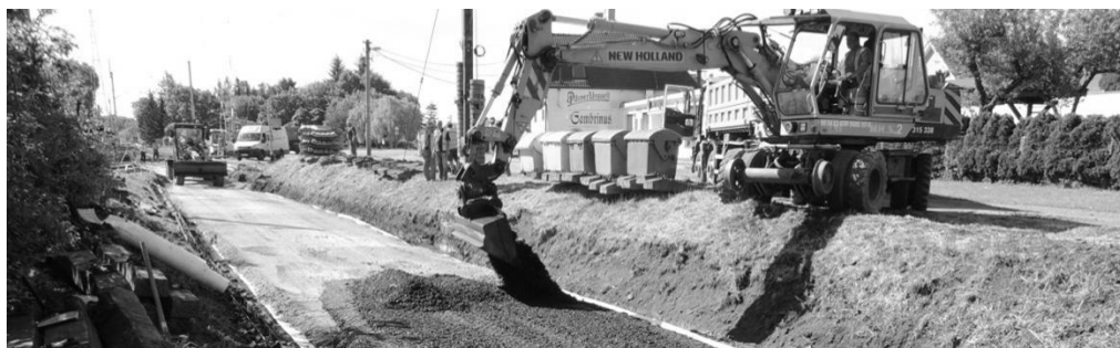
Obrázek č. 3 – Výstavba zkušebního úseku ve Štáhlavech
