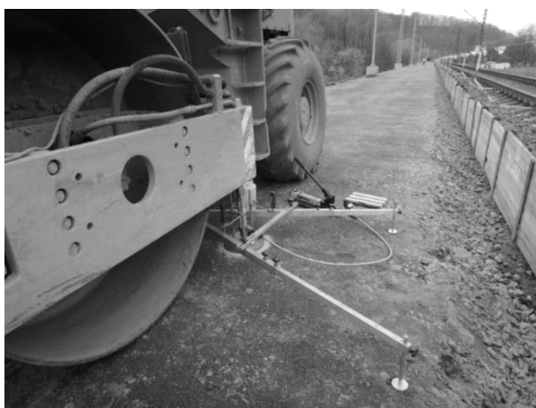
Obr. 3. Měřicí kampaň na reálné stavbě železniční trati v ČR.
