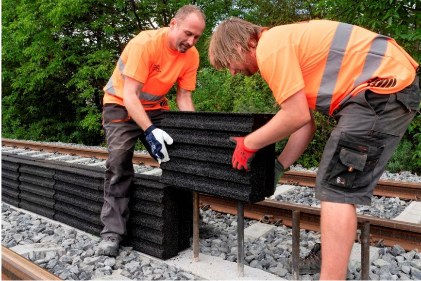
Obr. 2 Výstavba MPHC v lokalitě Praha Hloubětín.
